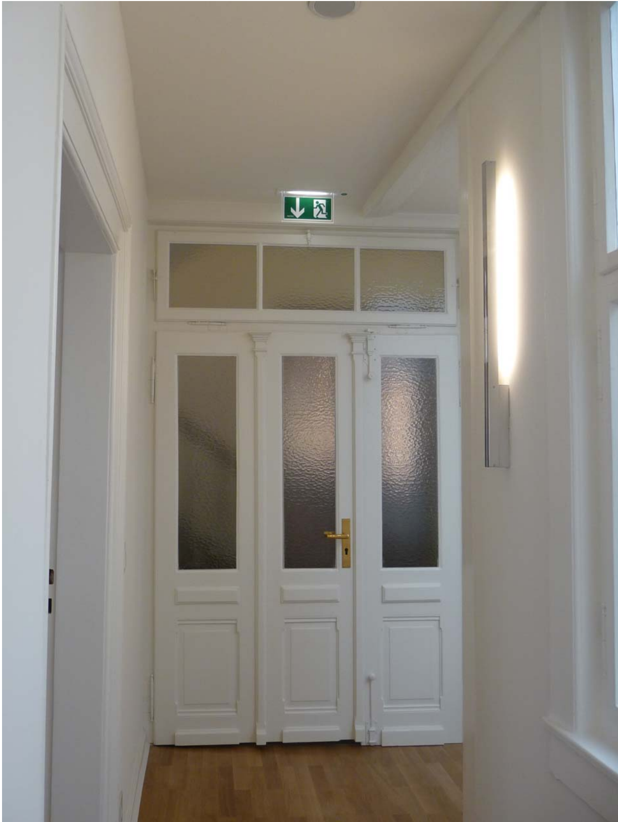
Abbildung 4: Sanierte/Restaurierte Türe im Altbau
