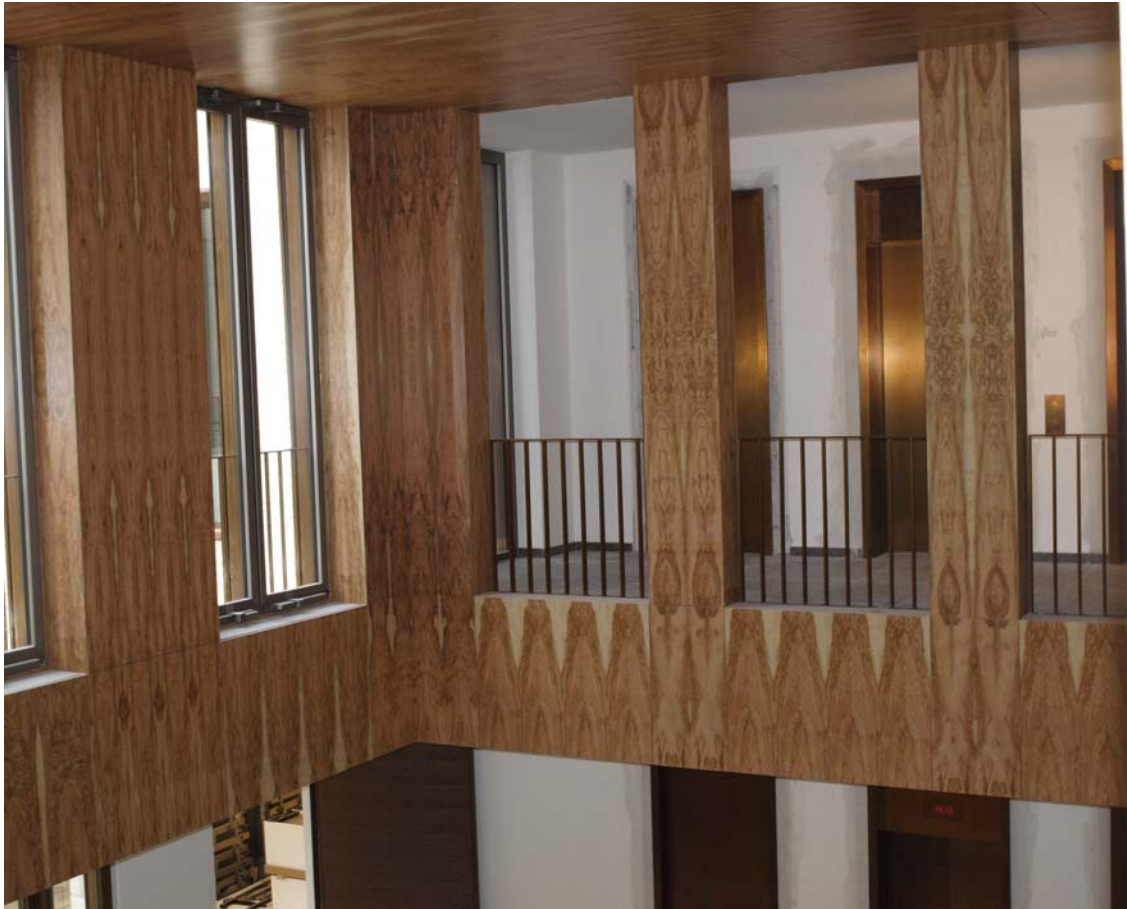
Abbildung 3: Nahezu fugenlose Abwicklung von mehrseitiger Säulen-/Wandverkleidungen und Decke
