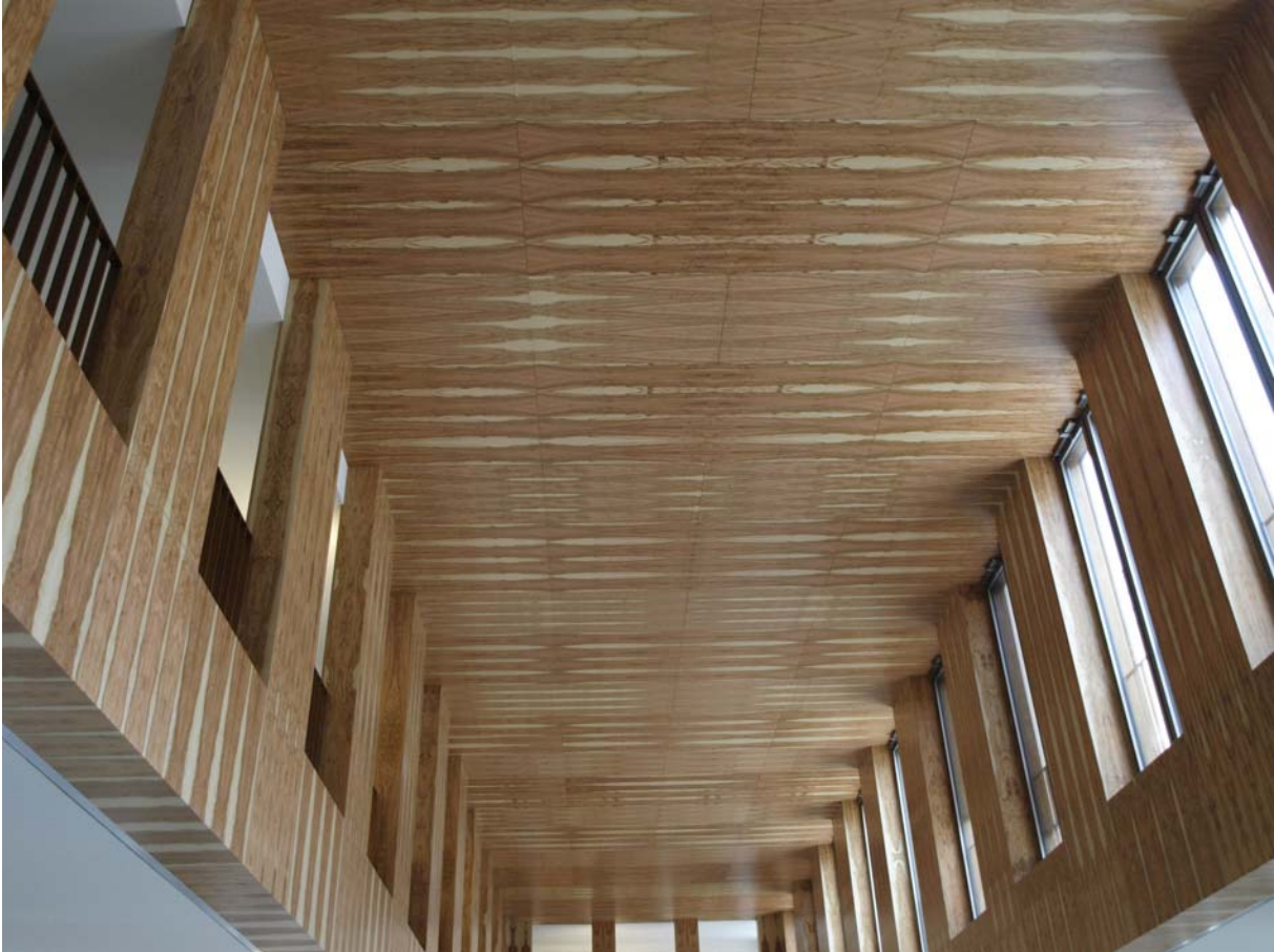
Abbildung 1: Wand- und Deckenverkleidung in Olivenbaum furniert
