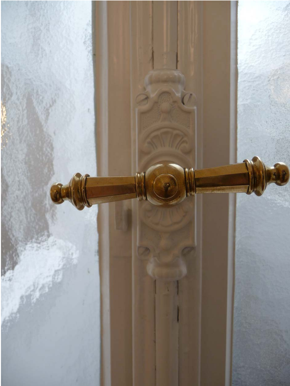
Abbildung 6: Detail aufgearbeiteter Fensterbeschlag
