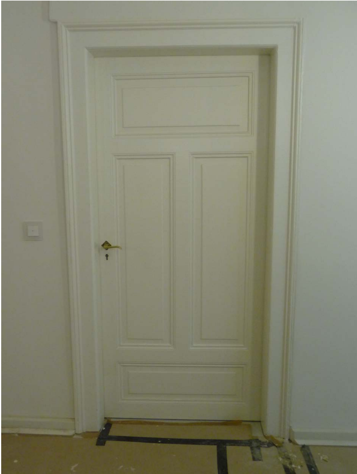
Abbildung 7: Neue Ersatztüre im alten Design (Original Türdrücker noch nicht montiert!)
