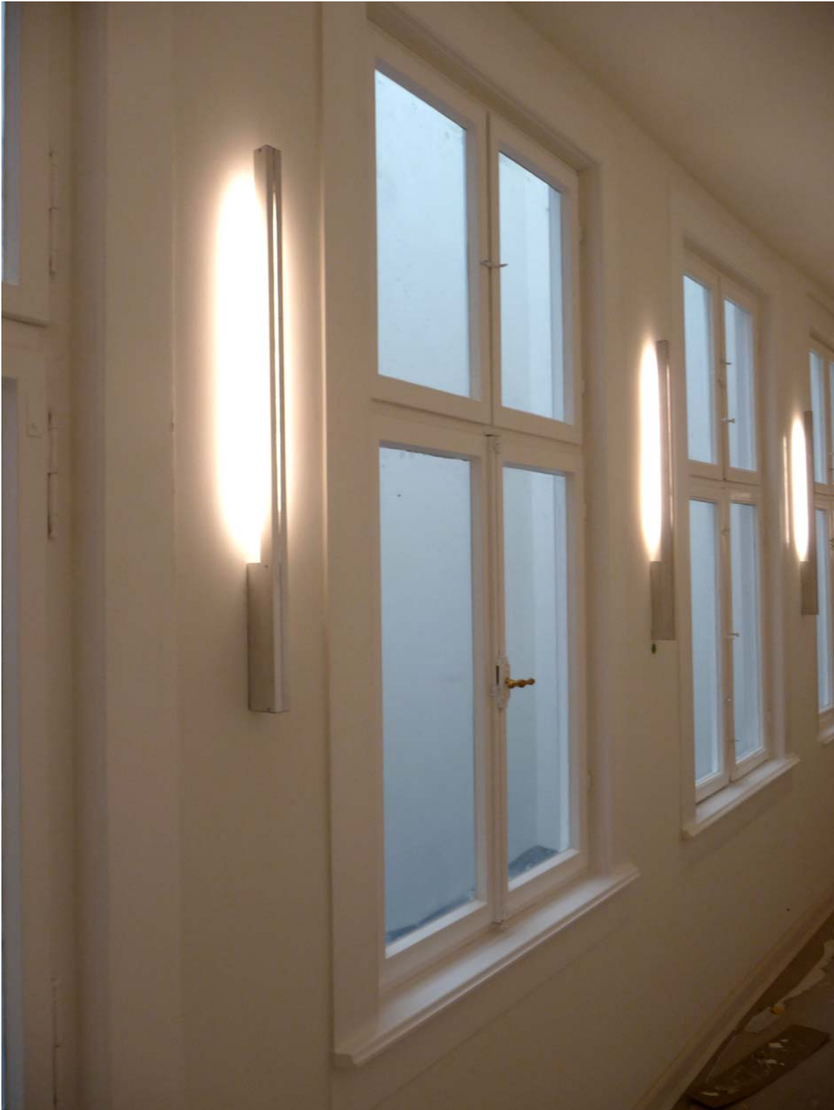
Abbildung 5: Restaurierte Fenster im Altbau, inkl. Aufarbeitung der Beschläge
