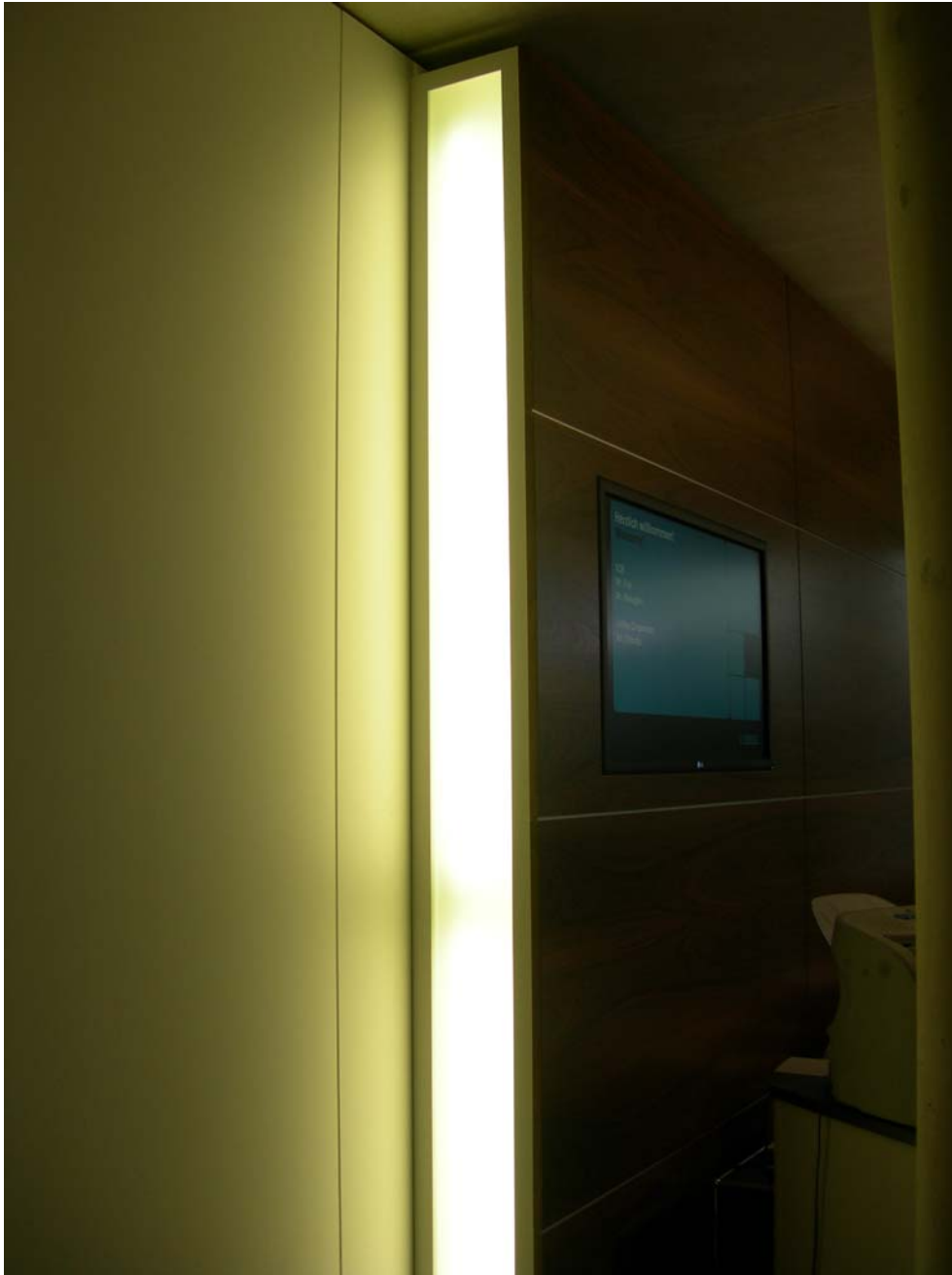
Abbildung 5: Indirekte Beleuchtung der Medienwand
