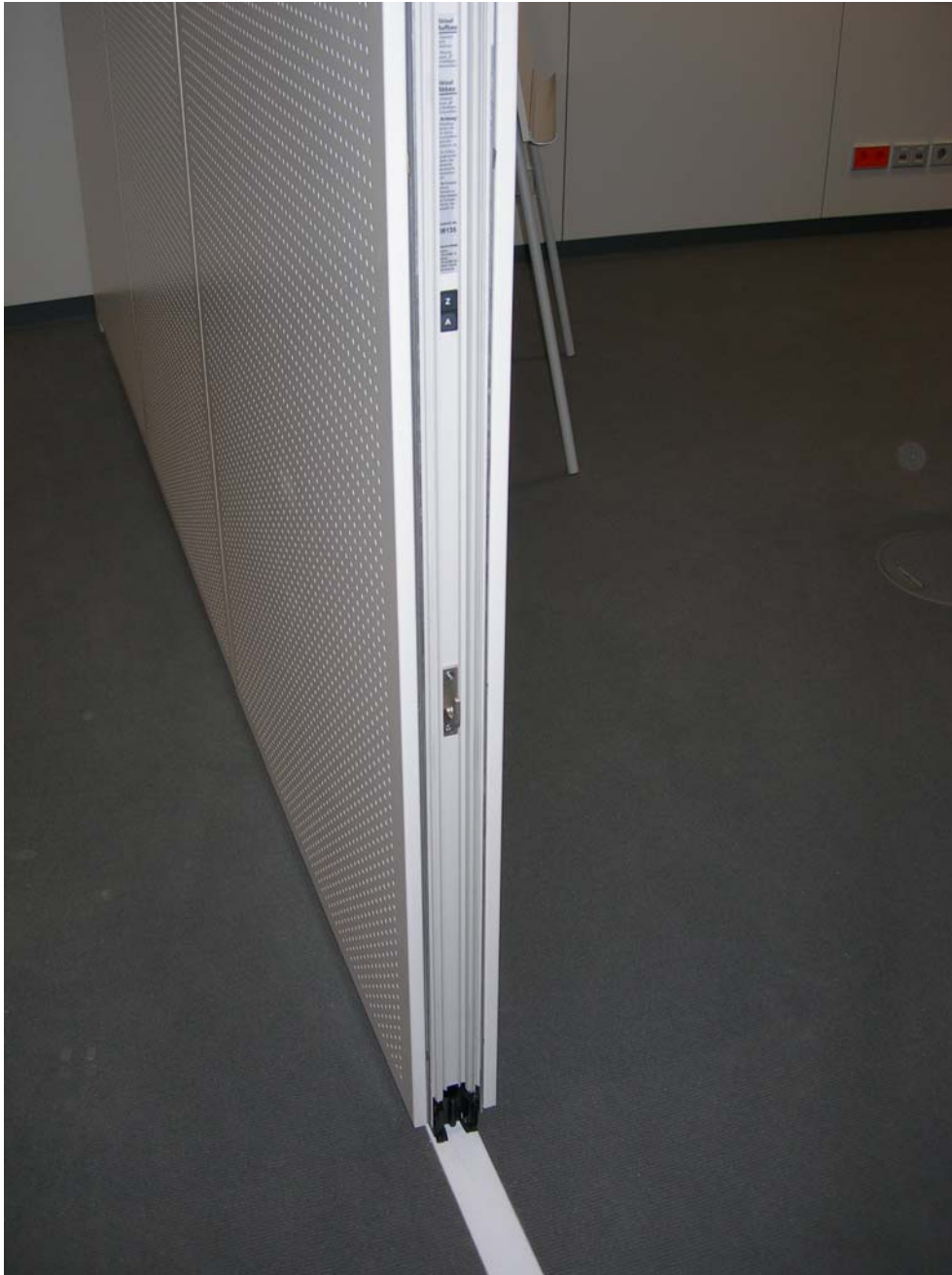
Abbildung 3: Mobile Trennwand Detailansicht motorische Feststellung
