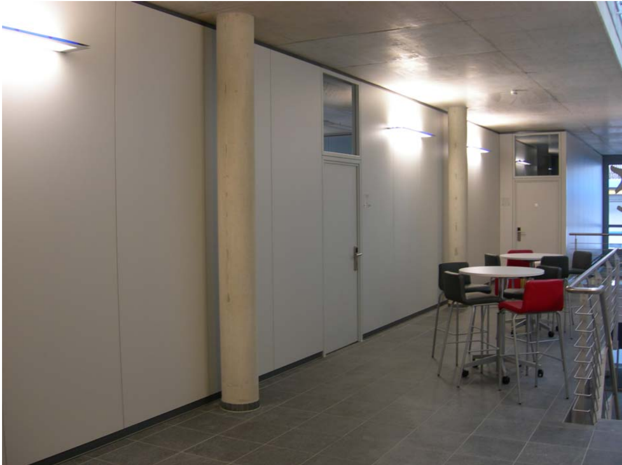
Abbildung 6: Bürotrennwände mit Feuerschutzfunktion (F90)
